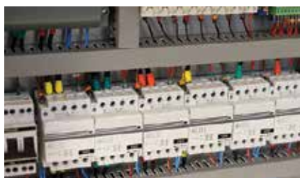
Figura 130 – Siguranțe electrice automate
