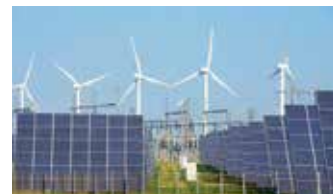
Figura 6 – Ferma solară și eoliană
